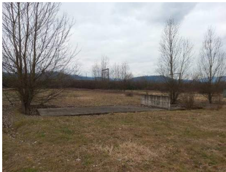
Figura 16 protezione della tubazione del gas
