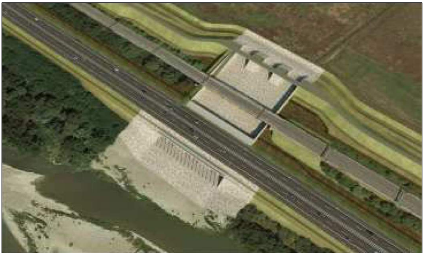
Figura 9 opera di presa sul fiume Arno
